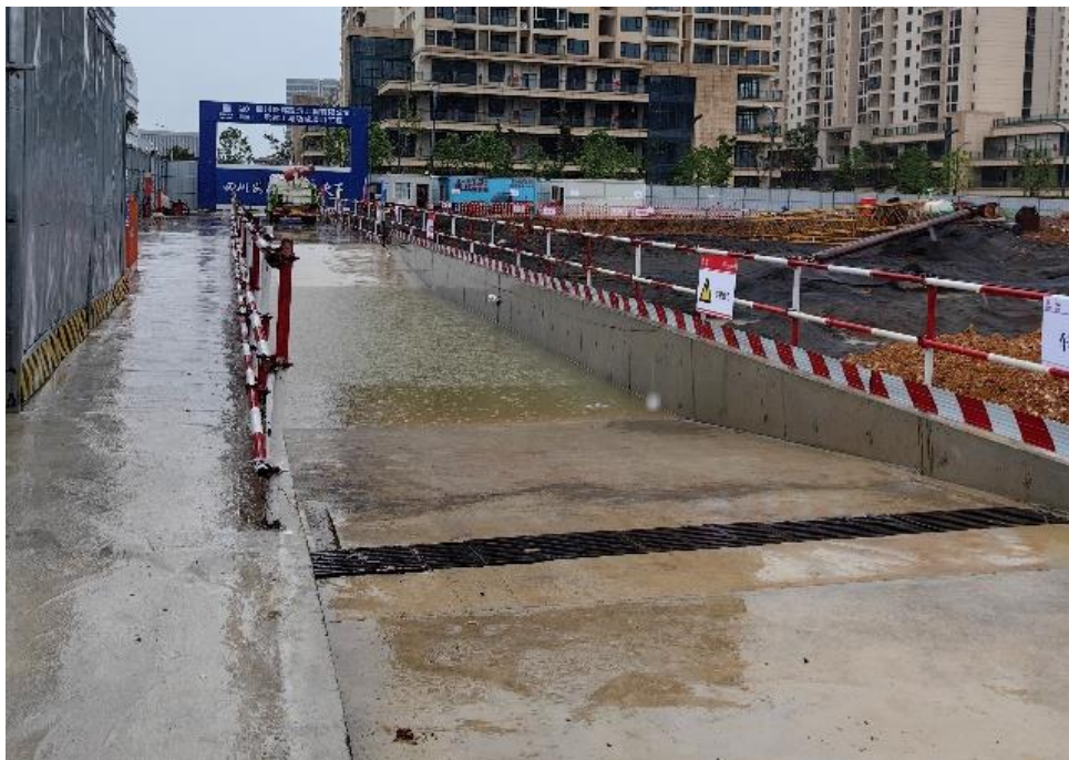
图 2.2-2 施工场地车辆清洗池现状
